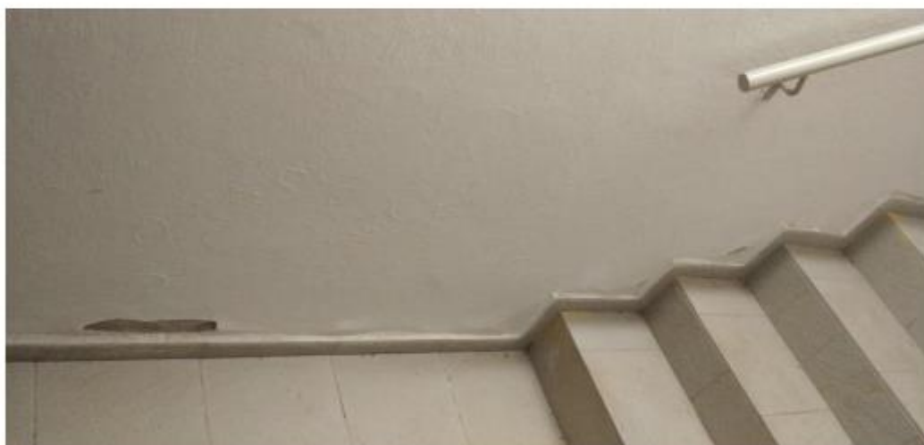
13. poškození opravené omítky
