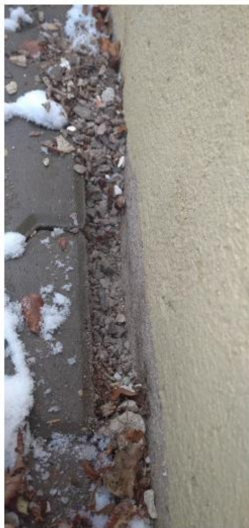
17. chybějící svislá izolace
